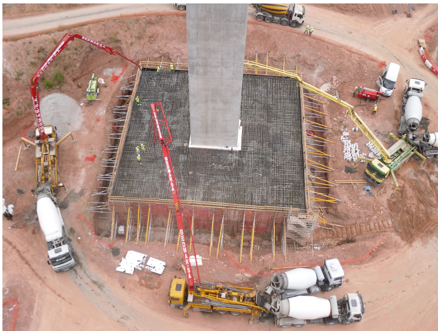
Figura 1: Hormigonado de zapata en el Pont del Candí (fuente: Angel Barba)
