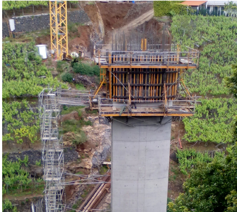
Figura 4: Encofrado trepante en la construcción de la pila de un puente ( fuentes: Ulma )
