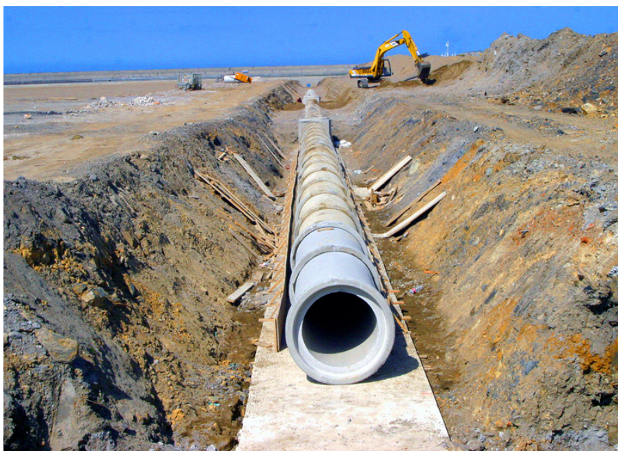
Figura 2: Tubería colocada en zanja (fuente: Prefabricados Alberdi)
