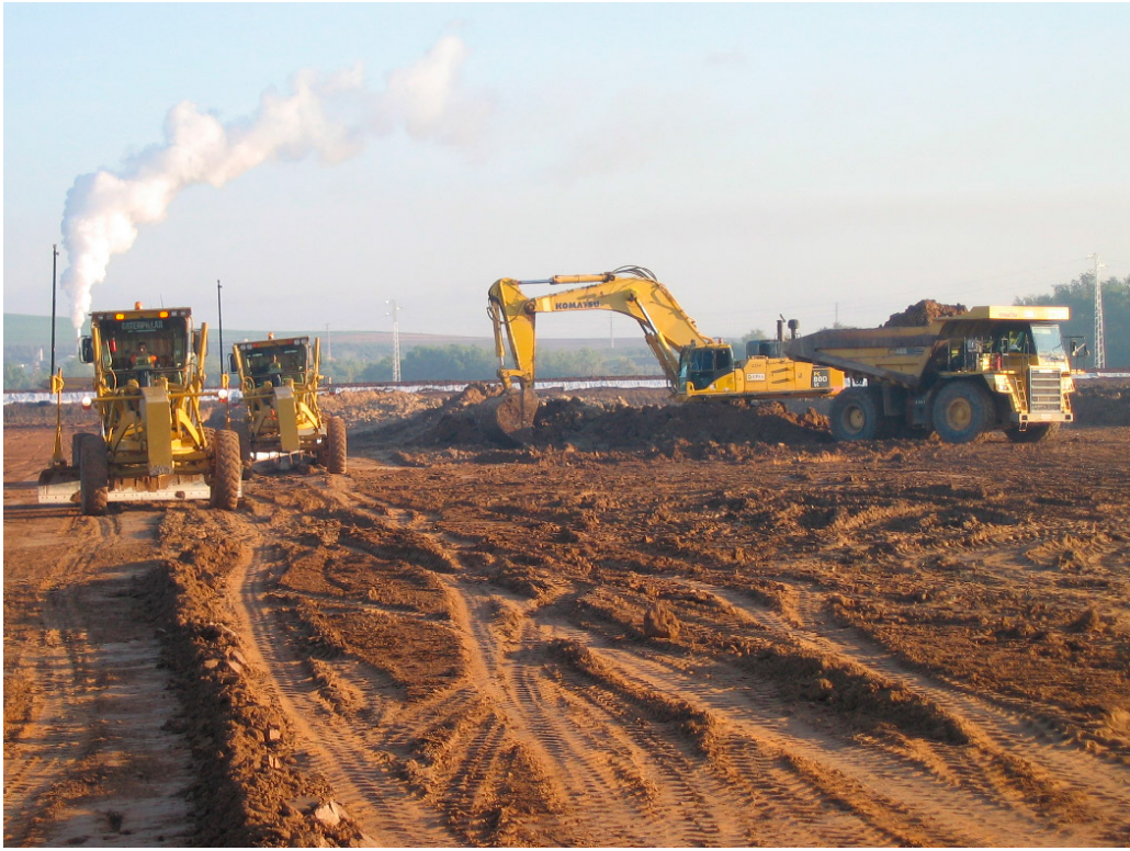
Figura 3: Operaciones de extendido y nivelación de un terraplén (fuente: Macías Flores)
