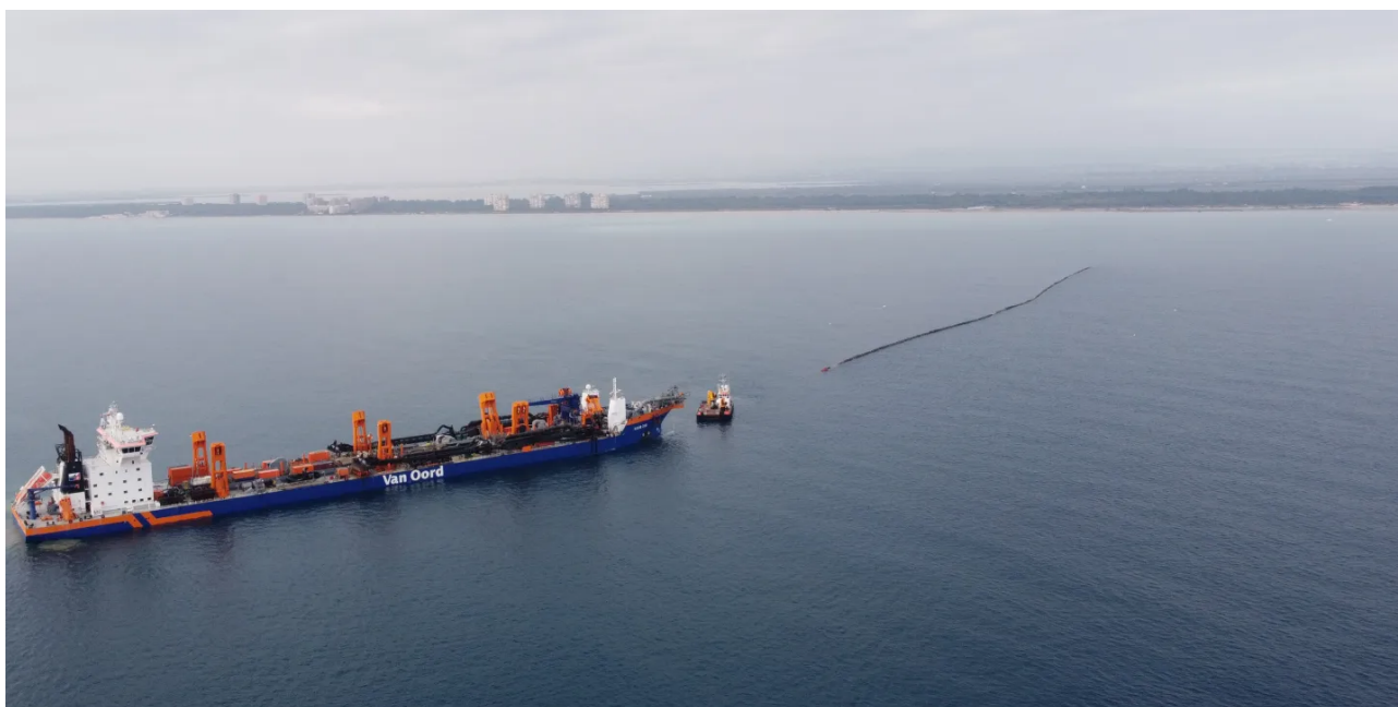
Figura 1: Equipo de dragado en la restauración de las playas del Saler, en Valencia ( Van Oord ).
