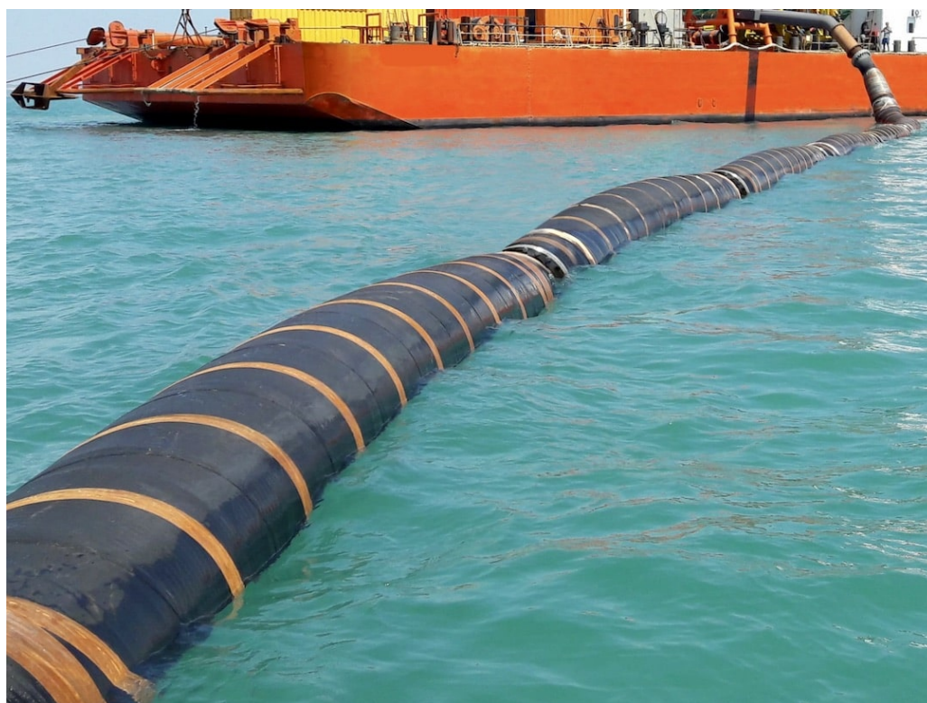
Figura 29: Tubería flotante de transporte de material dragado ( Park )
